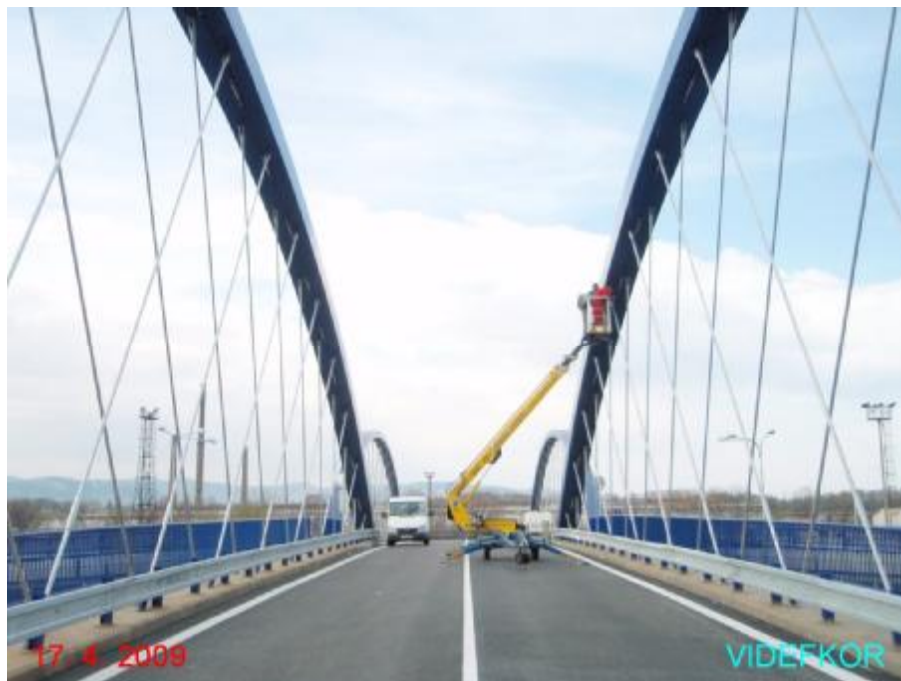
Silniční most, Třinec - Baliny
