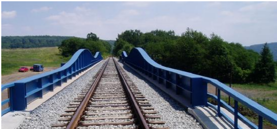
Železniční most, Varvažov
