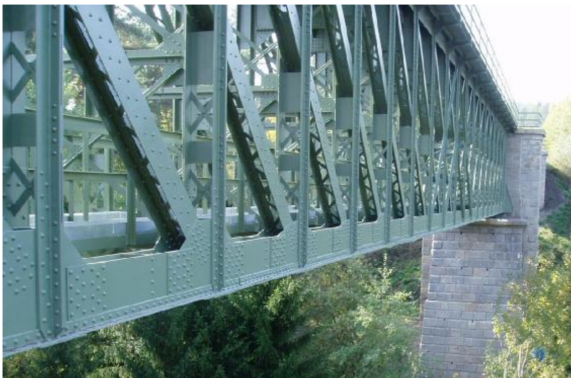
Železniční most, Plasy
