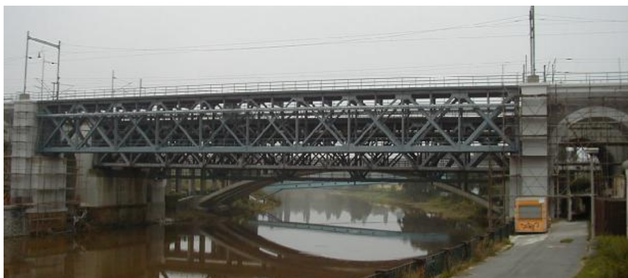
Železniční most, Plzeň
